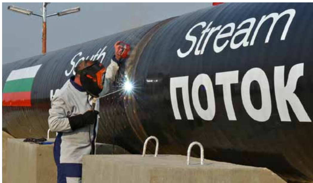
Сварка первого стыка болгарского участка газопровода «Южный поток».
