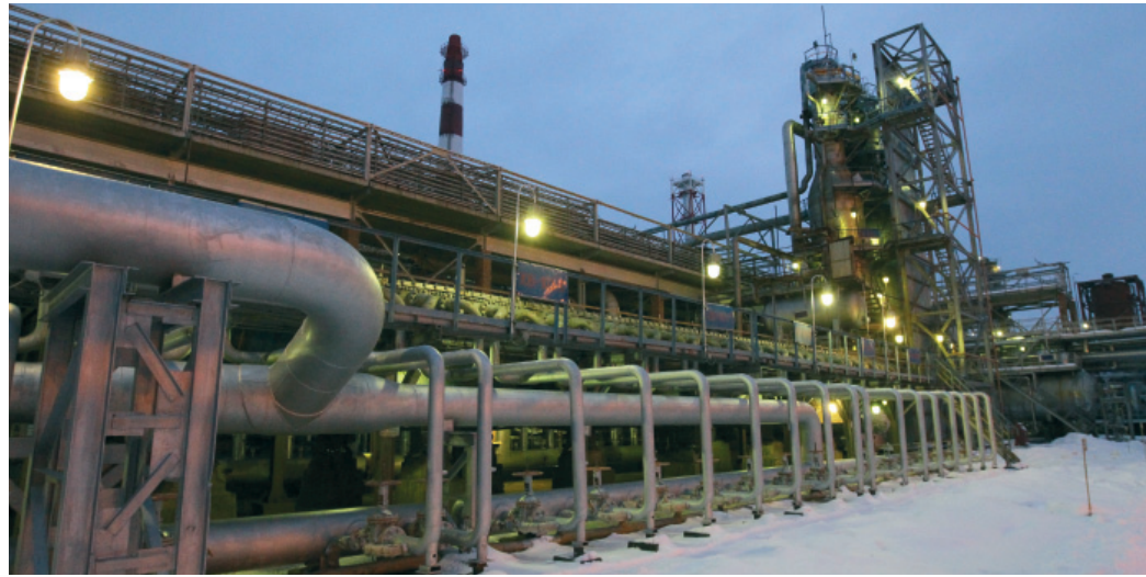
Реакторный блок комплекса облагораживания моторных топлив. Именно здесь с дизельной фракцией происходят важные химические превращения, улучшающие ее качества. Фото Д. Пихновского
