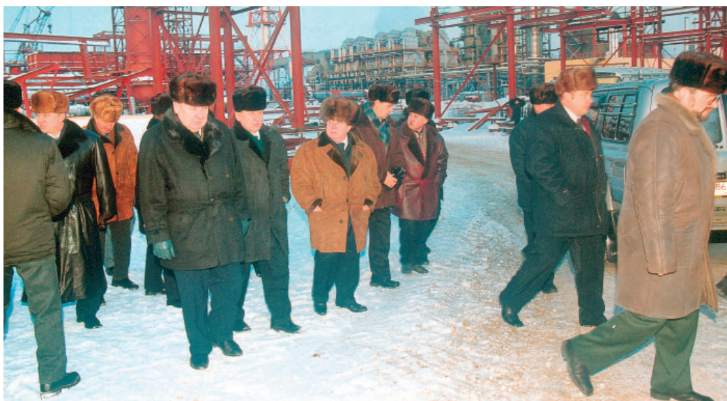
Председатель Правления ОАО «Газпром» Рем Вяхирев на территории строящейся ЛКС 35-64, 1999 год. Фото В. Пихновского
