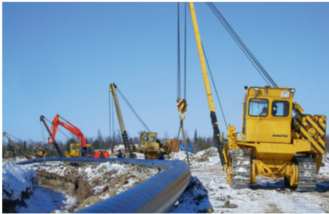
Очередной ремонт конденсатопровода
