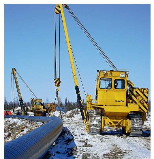
Конденсатопровод «Уренгой — Сургут», участок 0,4–16 км, капитальный ремонт
