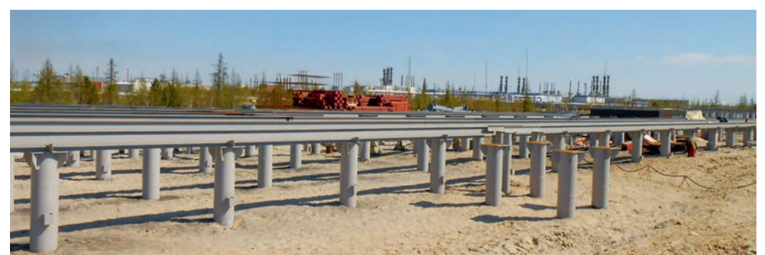
Основание под блочно-модульное здание ГНС-2
