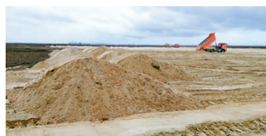
Отсыпка площадки под строительство Установки стабилизации конденсата
