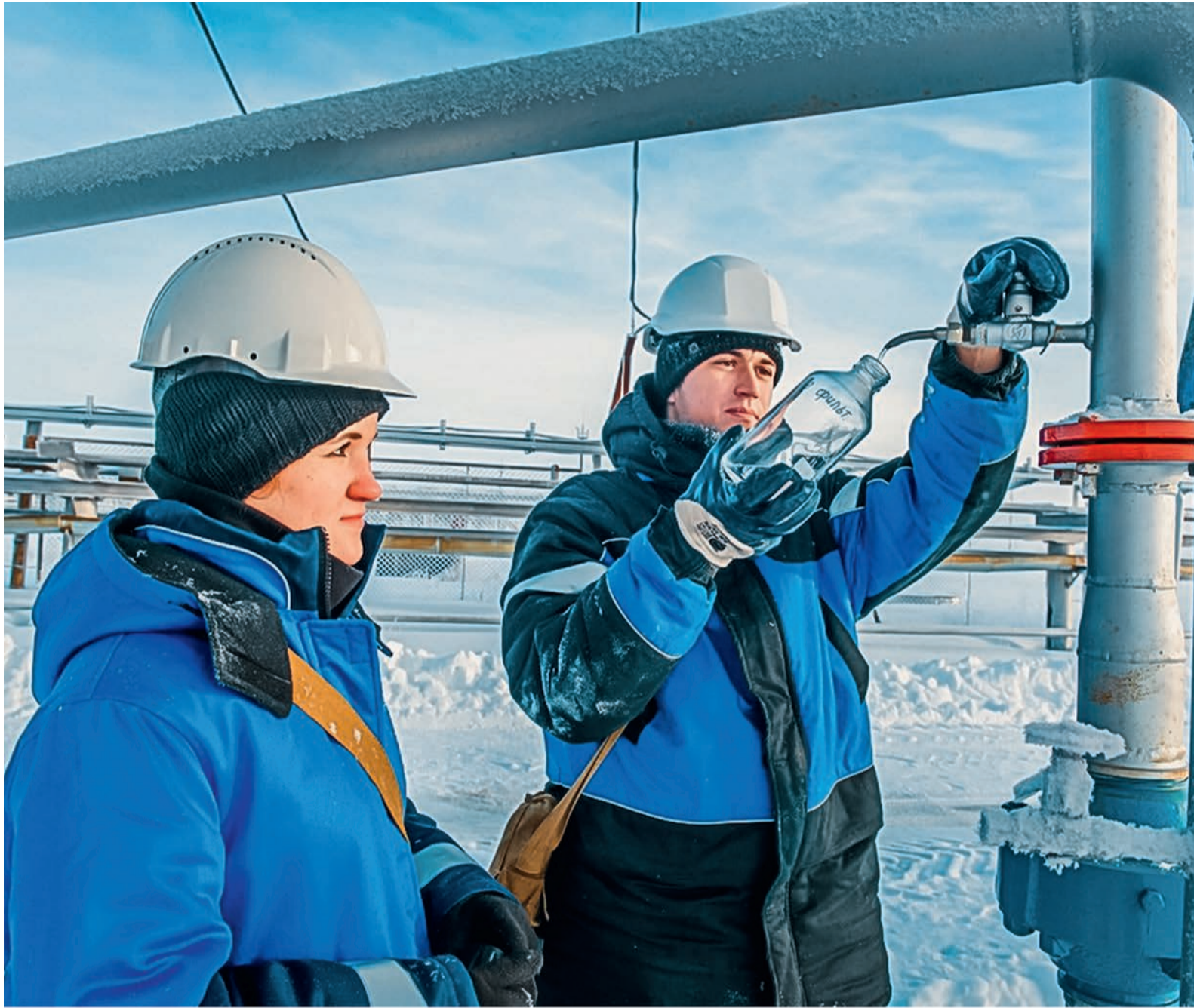
Завод по подготовке конденсата к транспорту: отбор продукта
