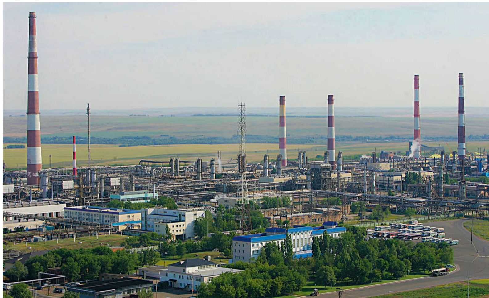
Оренбургский газоперерабатывающий завод
