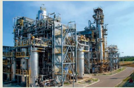
Сосногорский газоперерабатывающий завод
