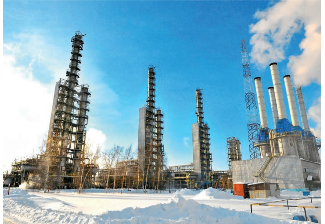
Установка по стабилизации конденсата Сургутского ЗСК
