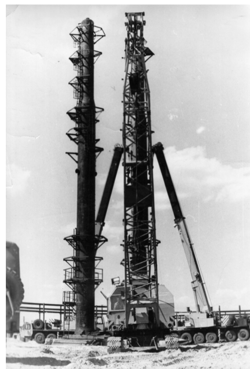
Строительство УСК. 1984 год
