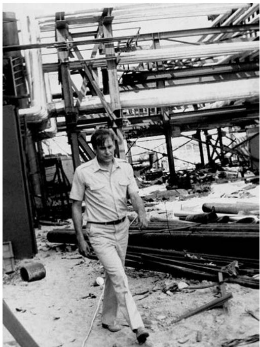
На строительной площадке УСК-2
