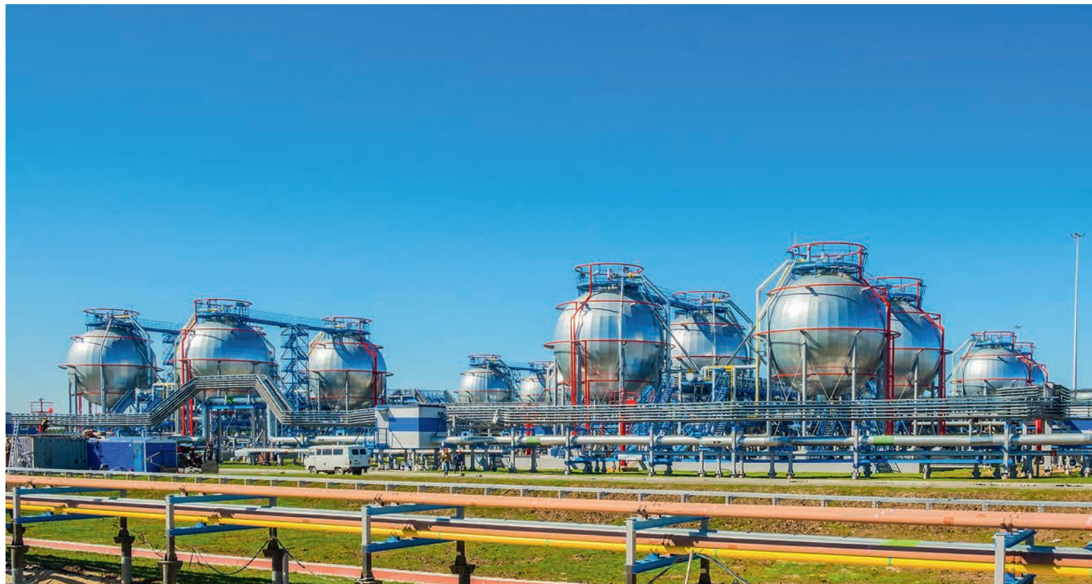
Объект «Расширение ЗПКТ, II очередь» — головная насосная станция № 2 (ГНС-2)
