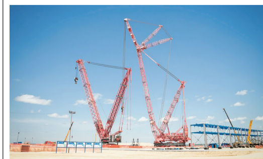
Кольцевой кран Liebherr грузоподъемностью 1600 тонн
