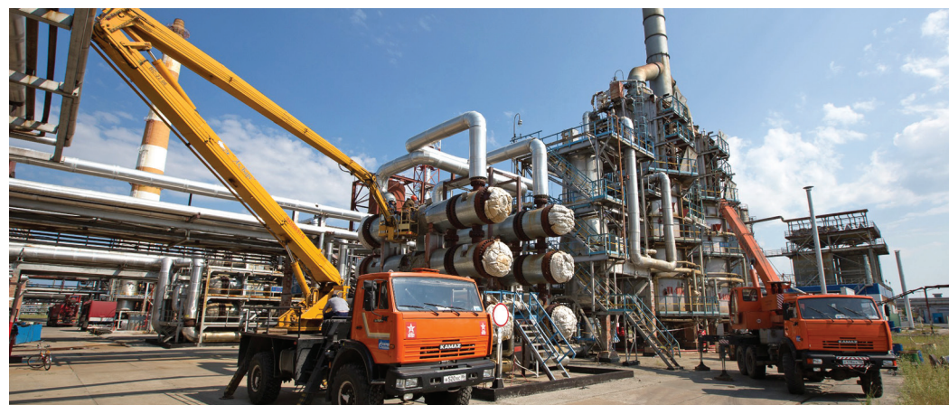
Ремонтные работы на комплексе по обогащению моторных топлив
