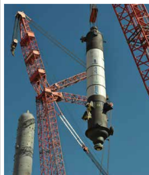
Спиральновитой теплообменный аппарат
