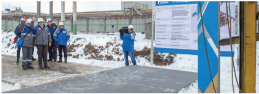
Торжественный запуск строительства нового производства серы
