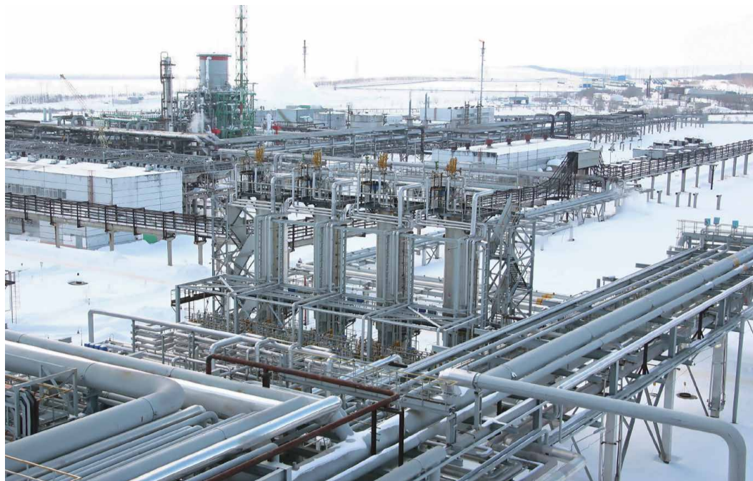
Вид на 3-ю очередь Оренбургского гелиевого завода
