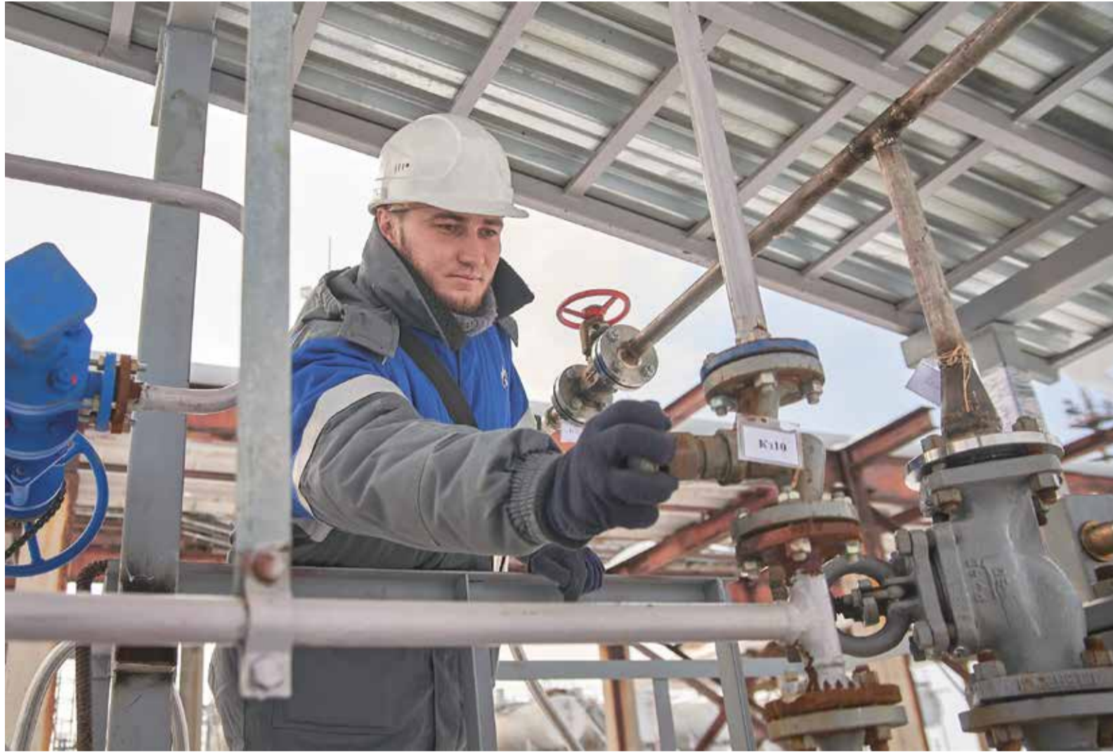
Процесс слива одоранта из емкости хранения в расходную емкость блока одоризации
