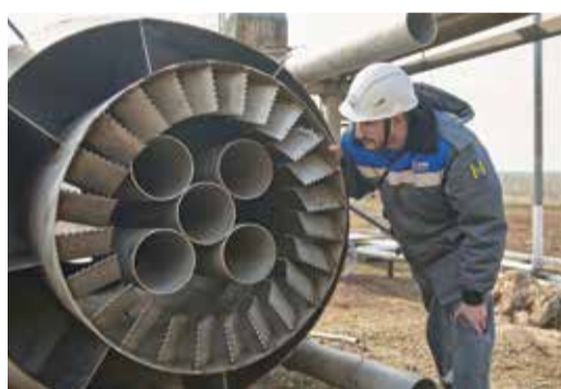
Мастер цеха МЦК Оренбургского гелиевого завода Станислав Фурсов проводит осмотр лопастей оголовка перед монтажом
