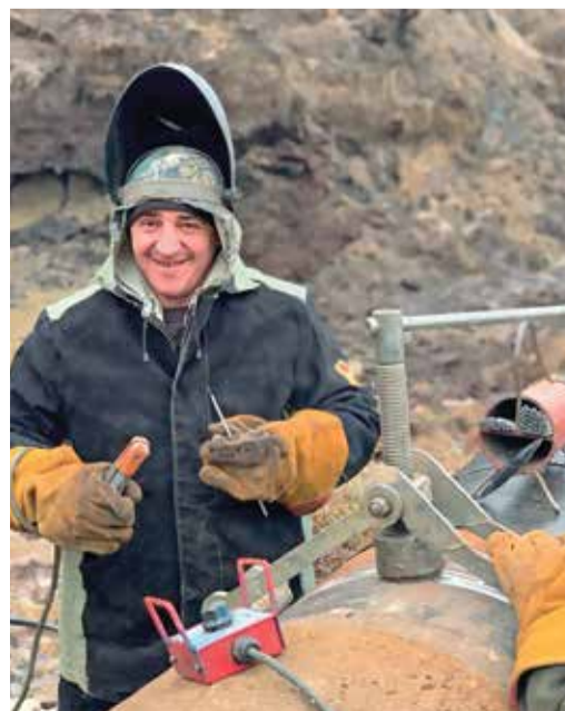
Работы на трубопроводе
