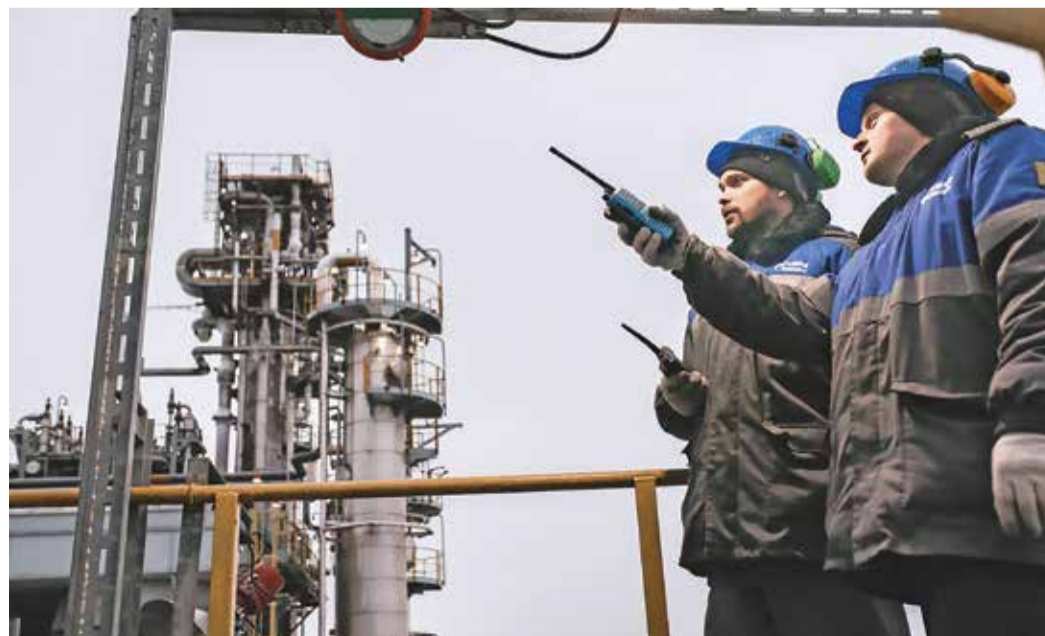
Цех по переработке природного газа. Установка низкотемпературного разделения газа
