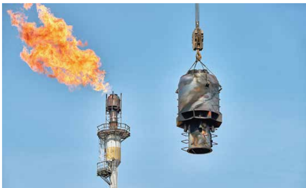
Демонтаж прежнего факельного оголовка
