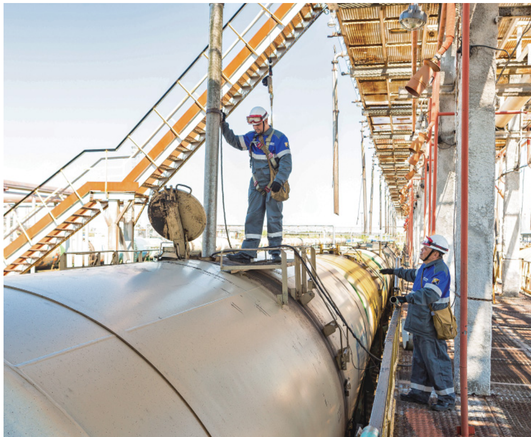
Отгрузка стабильного конденсата на Сургутском ЗСК
