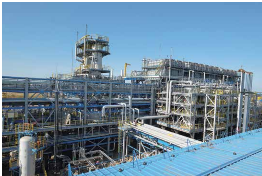
Новый перерабатывающий комплекс ДКС-УПГД
