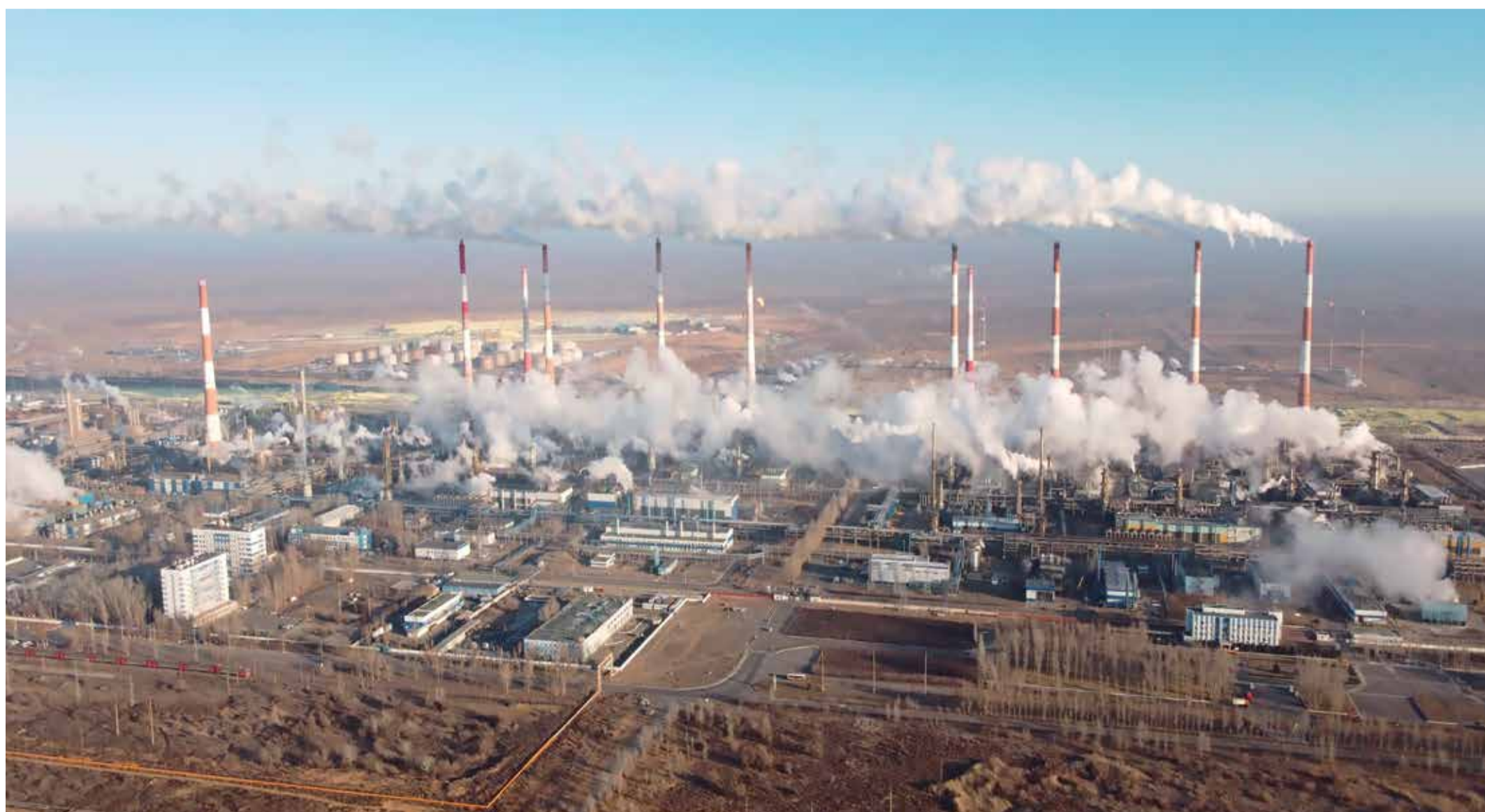
Астраханский газоперерабатывающий завод (вид сверху)
