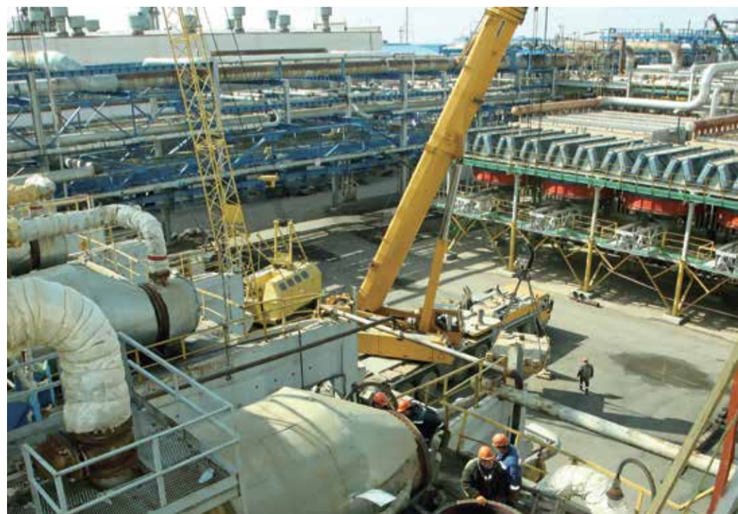
Плано-предупредительный ремонт на установке очистки газа от сернистых соединений
