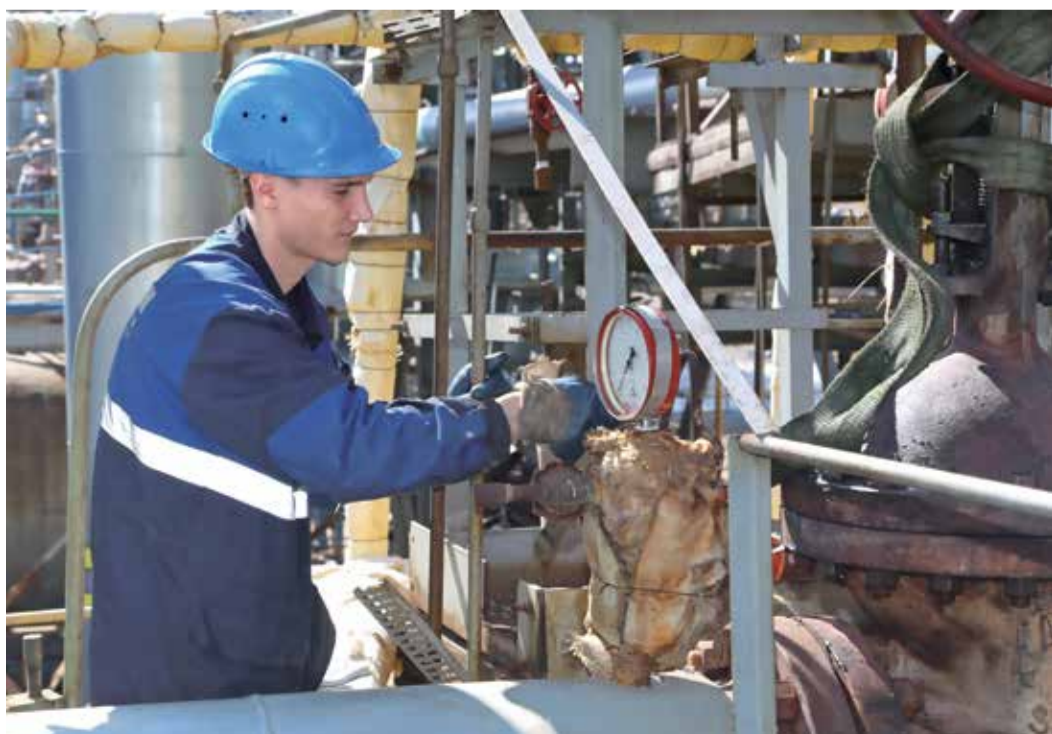
Ведется подготовка к демонтажу запорной арматуры
