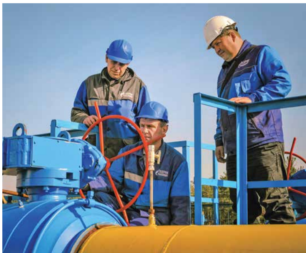
Работники Сургутской ЛЭС УТЖУ проводят работы на технологической обвязке узла учета
