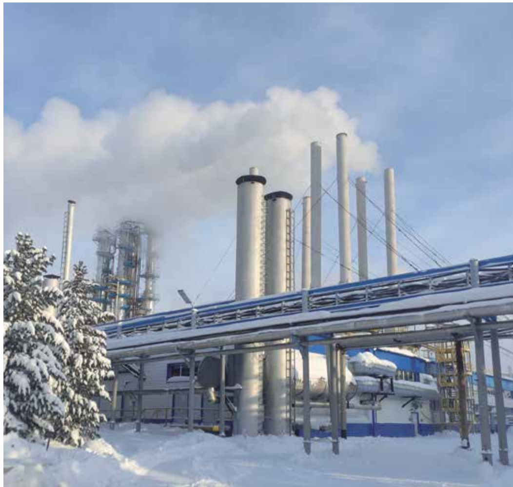
Печи установки стабилизации конденсата и установки получения дизельного топлива ЗПКТ
