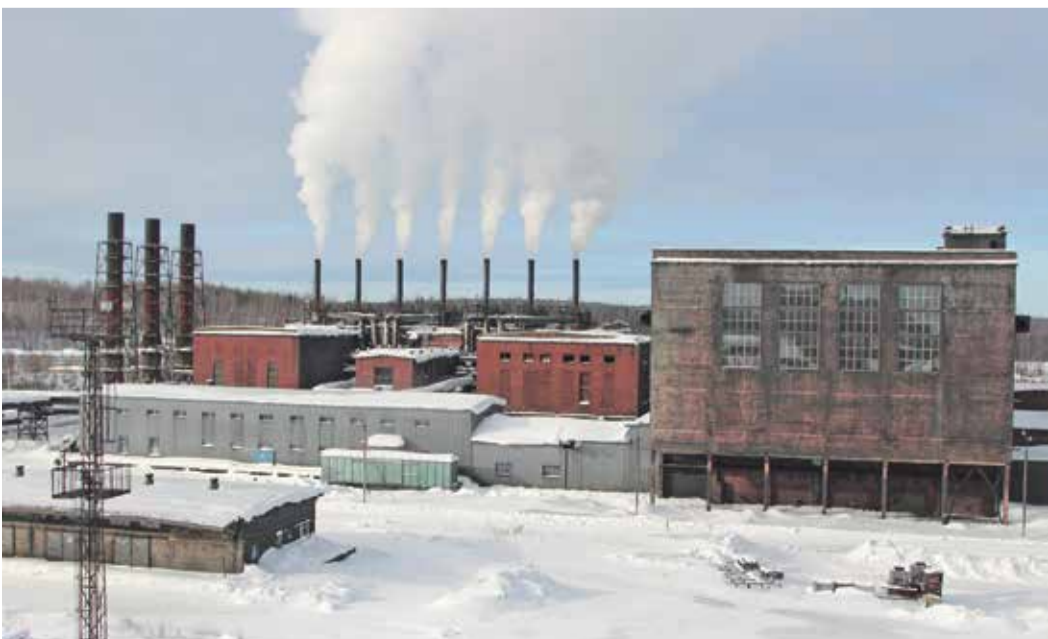
Цех № 3 по производству термического и печного технического углерода
