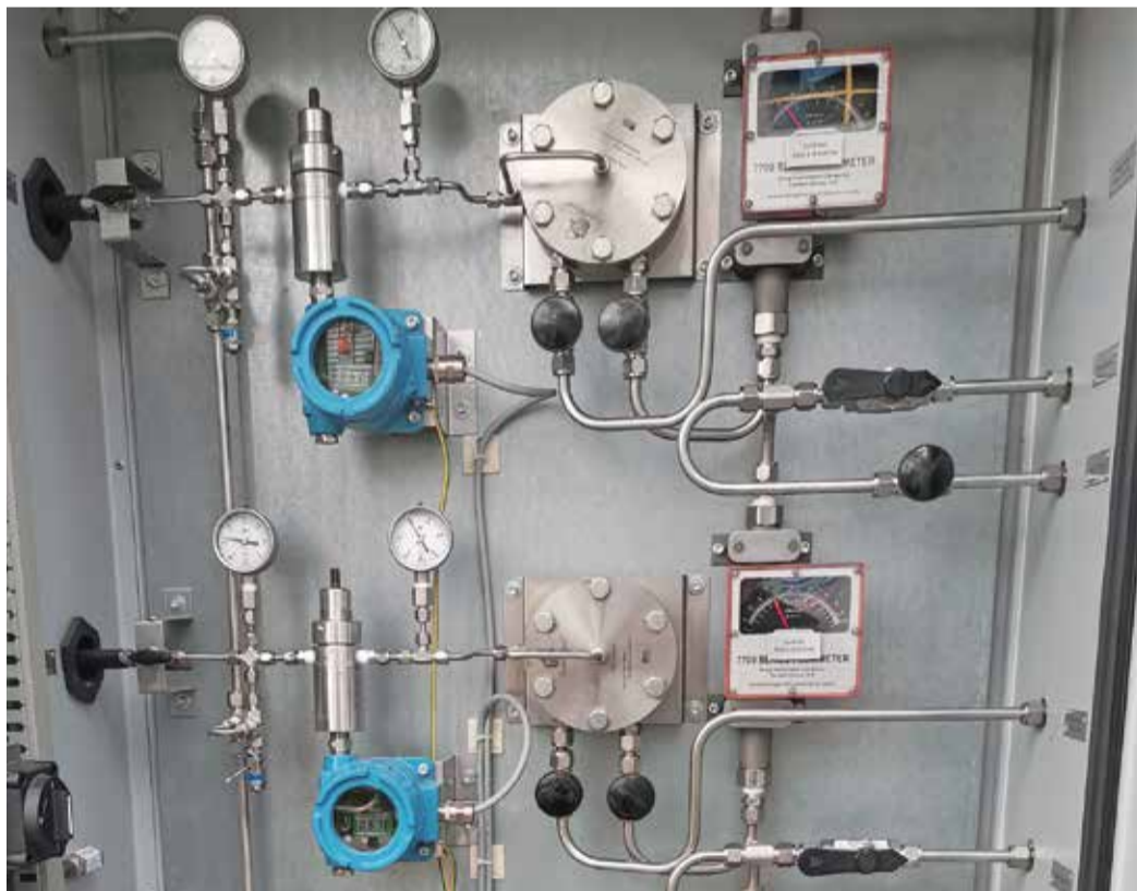
Система подготовки пробы для ее подачи на анализ в хроматограф
