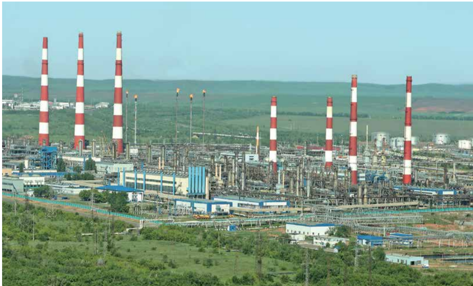
Оренбургский газоперерабатывающий завод с высоты птичьего полета
