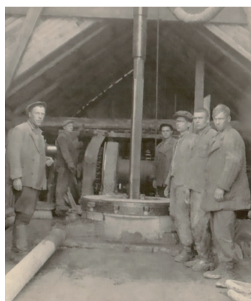
Бригада ухтинского газового промысла. 1944 год
