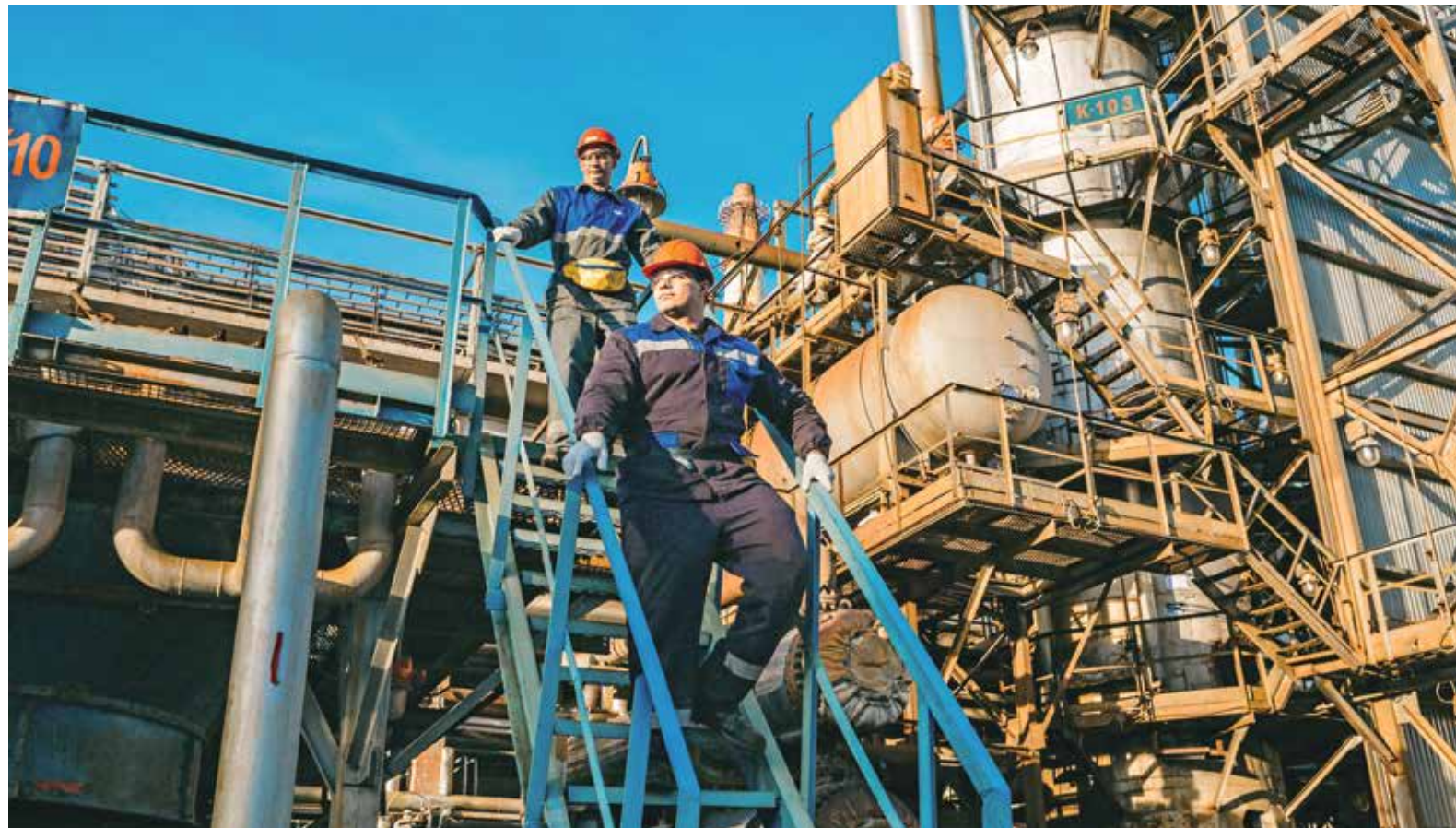
Установка в составе комплекса по облагораживанию моторных топлив Сургутского ЗСК
