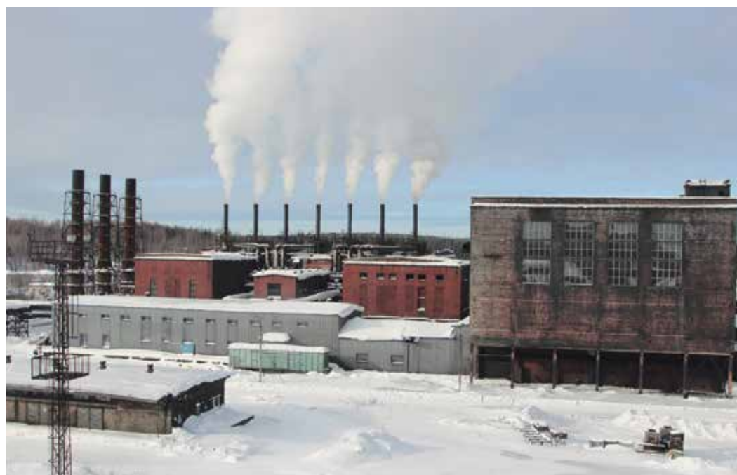
Цех по производству термического и печного технического углерода Сосногорского ГПЗ
