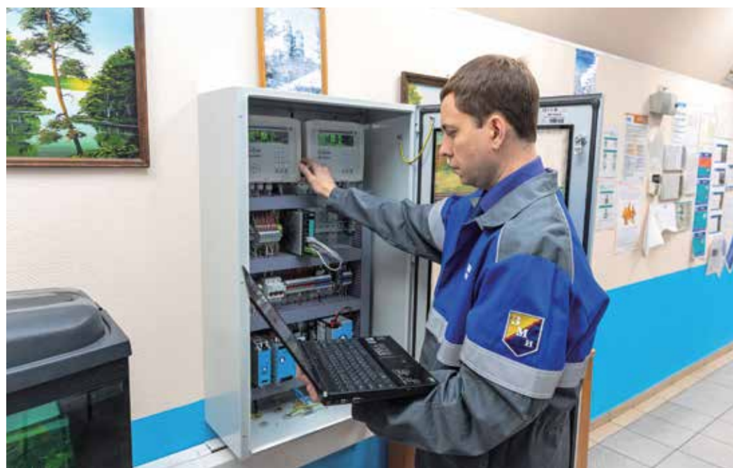
Контроль технического состояния и конфигурационных параметров вычислителя АБАК 3 в операторной установки моторных топлив Сургутского ЗСК
