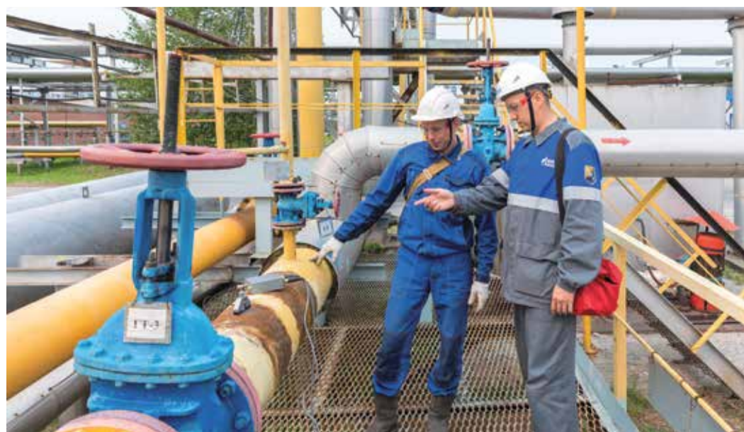
Диагностика межцеховых трубопроводов на Сургутском ЗСК
