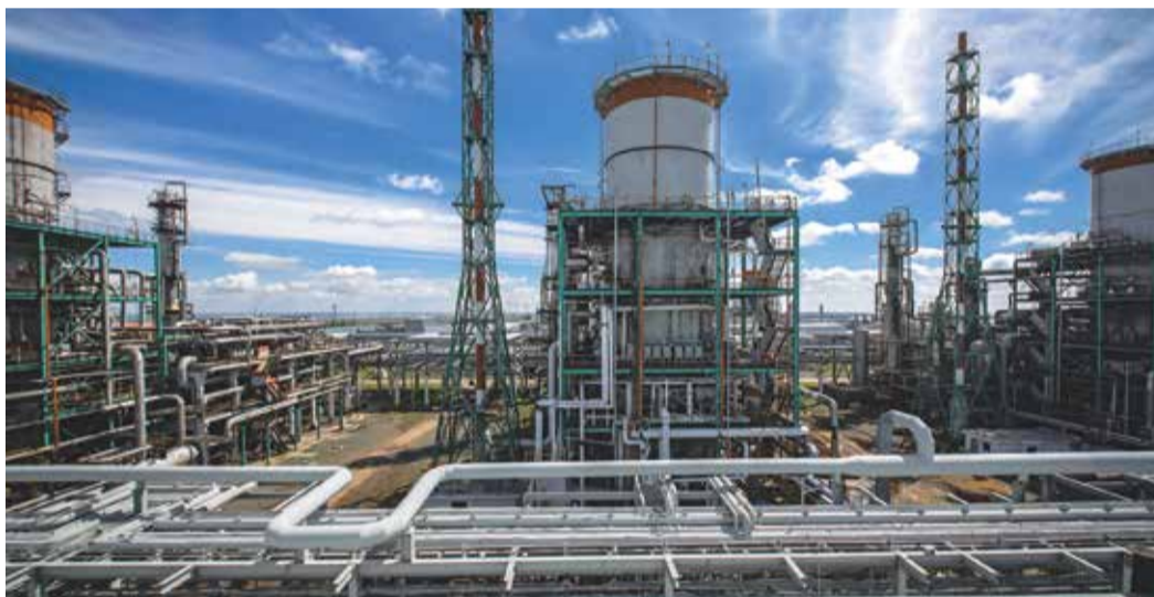
Гелиевые блоки – сердце Оренбургского гелиевого завода. Здесь из природного газа получают гелий, этановую фракцию и ШФЛУ
