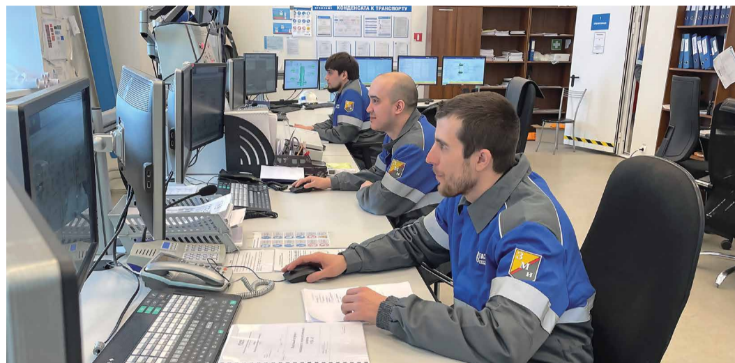
Операторная установки стабилизации конденсата ачимовских залежей
