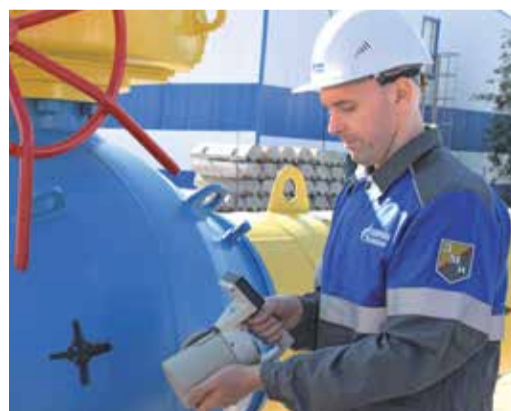
Работы по диагностике трубопроводов
