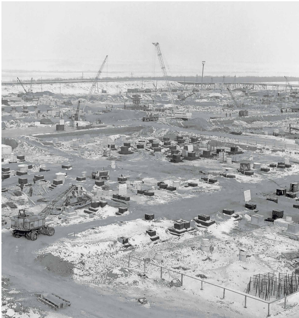
Строительная площадка третьей очереди ОПЗ, 1977 год
