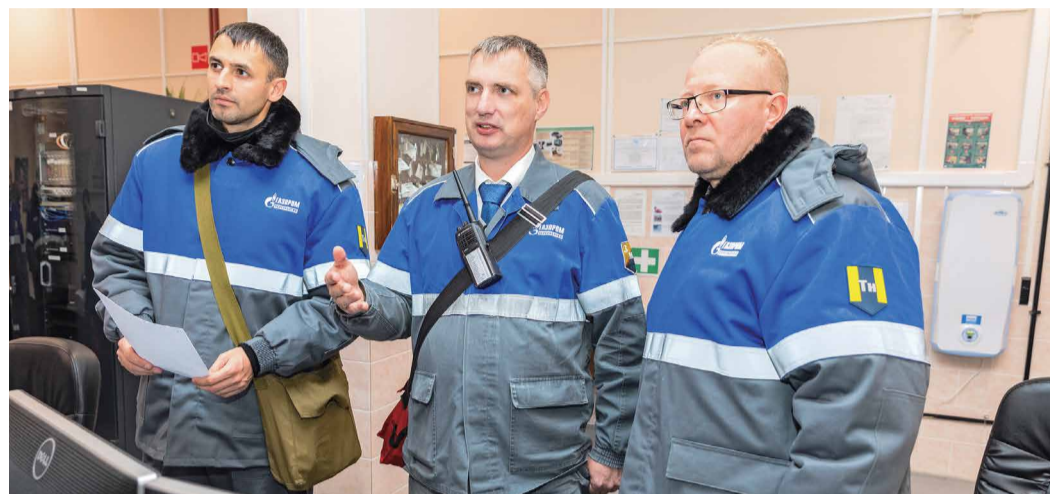
В операторной Установки по стабилизации конденсата
