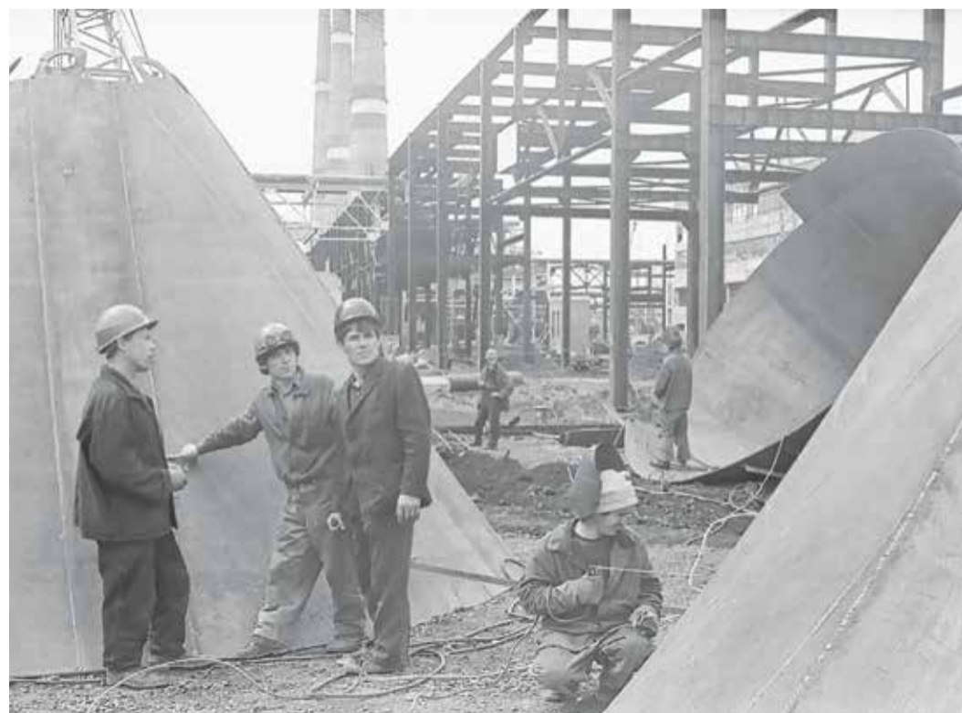
Рабочие на строительстве цеха № 1. 1973 год
